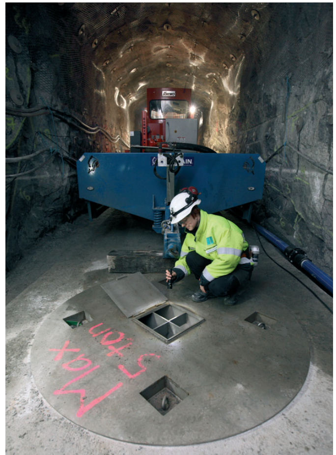
Kuva 8. Loppusijoitusporakone demonstraatiotunnelissa 1. Etualalla väliaikainen kansi ONK-EH7:n päällä.
