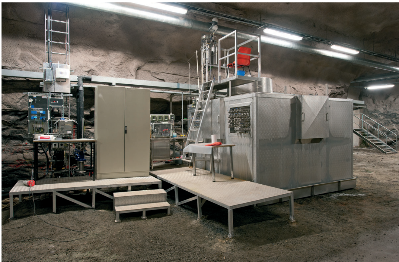
Kuva 16. Kaasunkehityskoelaitteisto Olkiluodon VLJ-luolassa.
