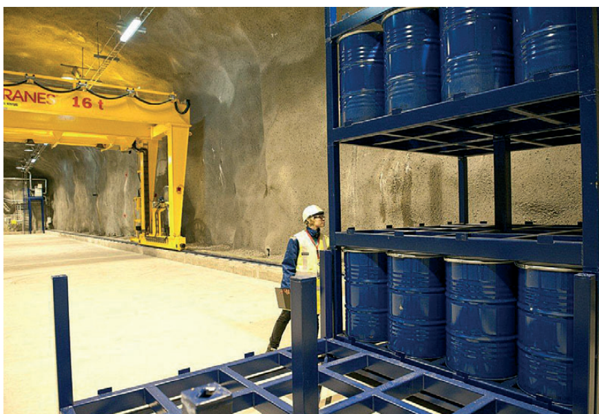
Kuva 20. Loviisan voimalaitosjätteen loppusijoitustilan uusi huoltojätetila, HJT3, jätteiden pitkäaikaiseen välivarastointiin valmistui vuonna 2011. (kuva: Ari Haimi)
