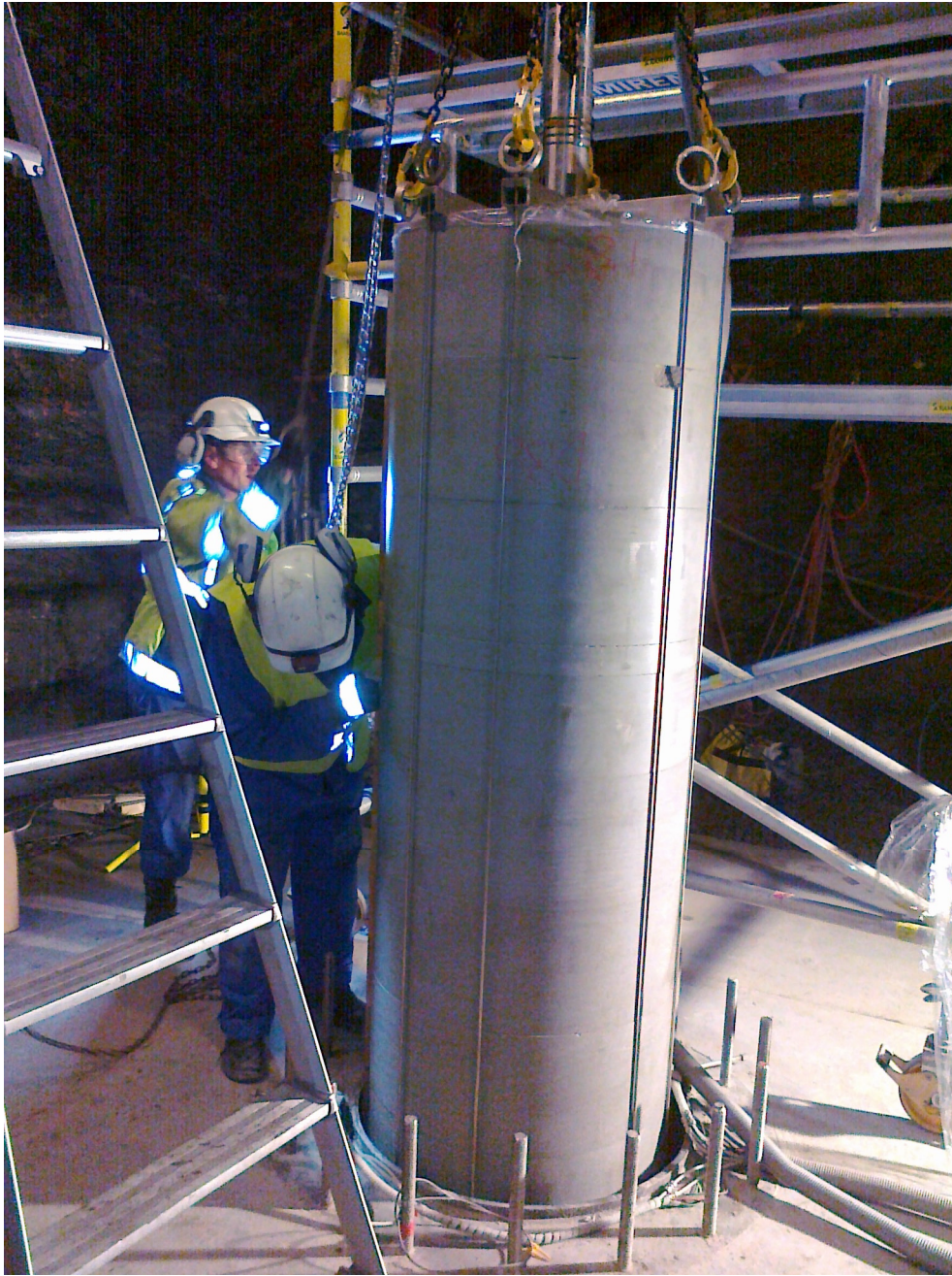
Kuva 4-40. Puskurikokeen asennus ONKALOn tutkimustilassa 1 (PL1475).
