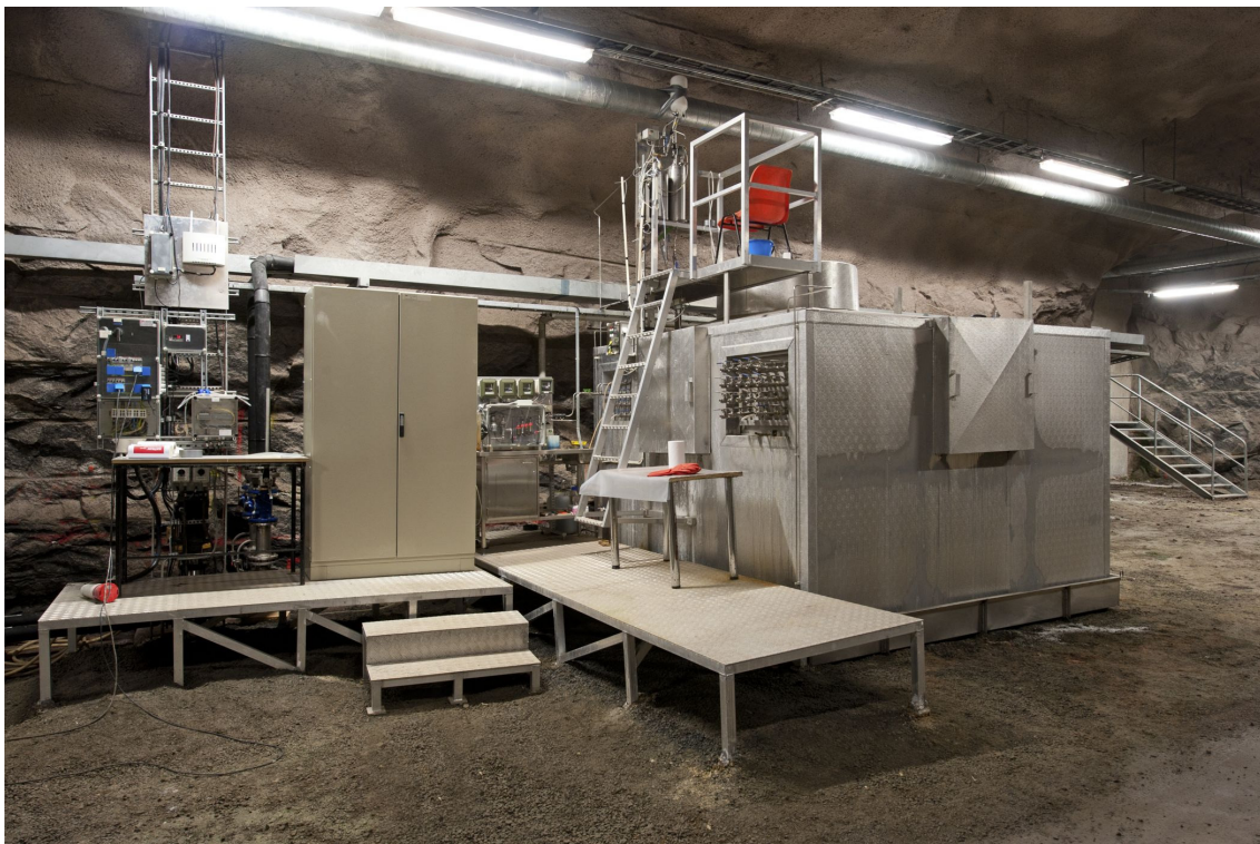
Kuva 8-1. Kaasunkehityskoelaitteisto Olkiluodon VLJ-luolassa.
