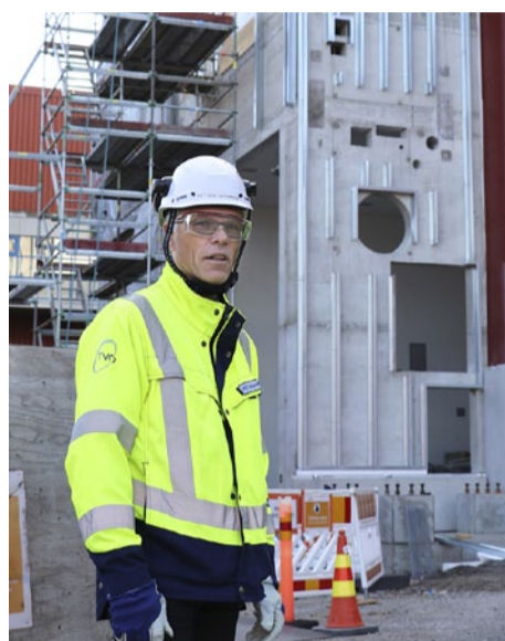
Projektin rakennustekniikasta vastaava TVO:n Petteri Salminen takanaan vanhojen dieselgeneraattorien vieressä harjaan nousutta uutta lisätilaa.
