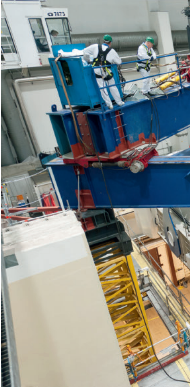
Päägeneraattorin vaihto oli OL1:n vuosihuollon suurin ja tärkein toimenpide.
