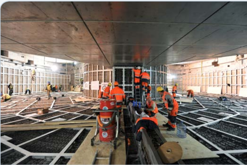
Työt meneillään reaktorilaitoksen suojarakennuksessa, hätäjähdytysvesiallas valmistuu.
