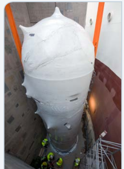
Suomalaisvalmisteisen paineakun nosto reaktorilaitoksella. Akkuja on kaikkiaan neljä.
