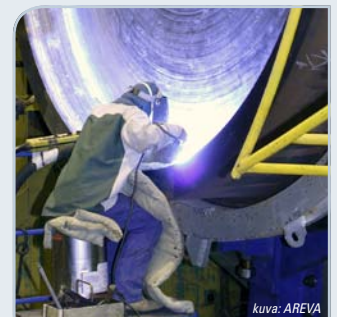
OL3:ssa on sitouduttu korkeaan laatukulttuuriin.
