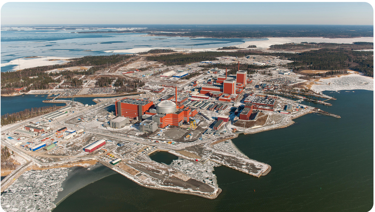
Bild 2. Flygfoto över kraftverksområdet.
