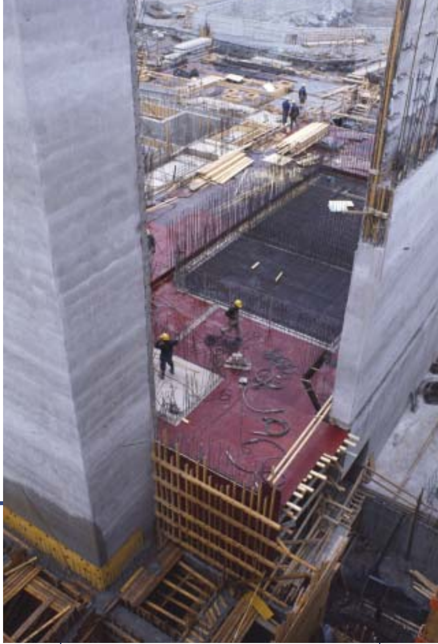
Olkiluoto 1:n työmaa.
