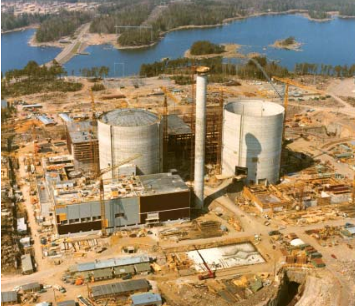
Loviisa 1:n ja Loviisa 2:n työmaa.
