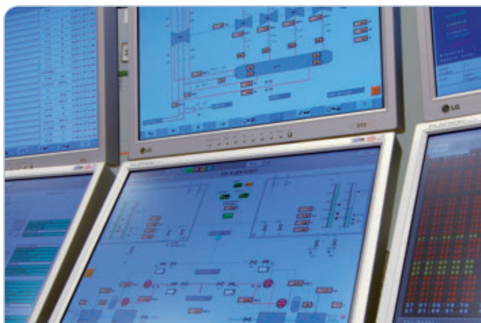
Turpiiniohjauksen näyttöjä. Simulaattorilla vuorohenkilökunta voi harjoitella laitoksen ohjausta käyttötoimintaa häiritsemättä.
