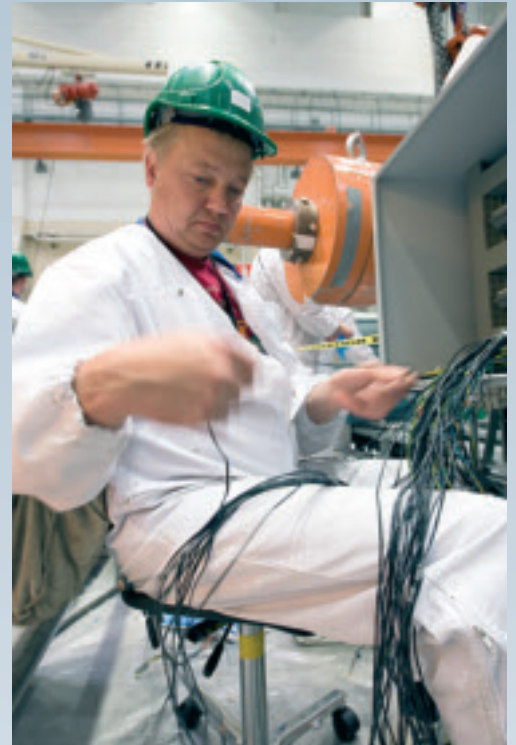
Riviliitinkotelon kytkentää.
