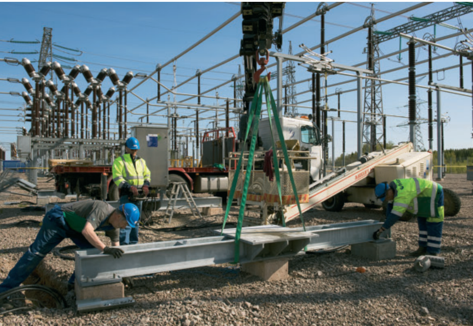
OL2:n laitoskatsaisijan uusintatyö meneillään.
