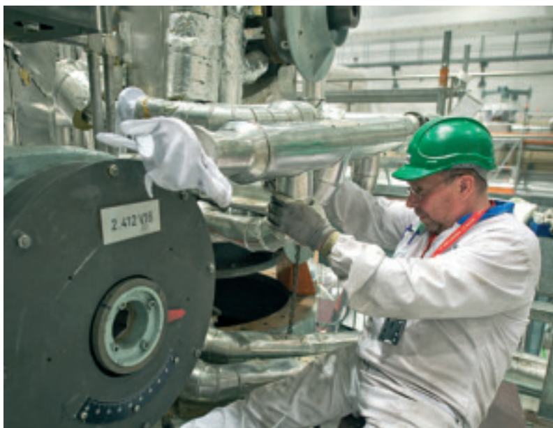
Matalapaineturpiinin höyryventtiilin vaihtoa.
