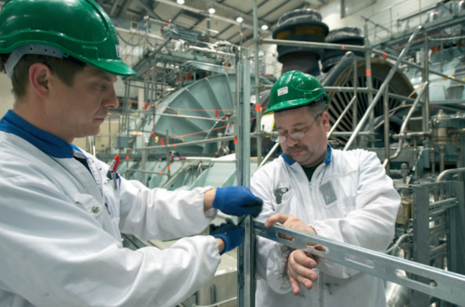
Riviliitinkotelon asennusvalmistelua ensi vuoden vuosihuoltoon.
