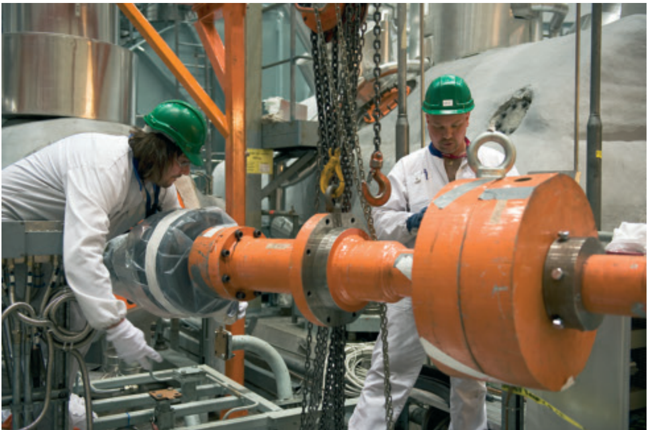
Korkeapaineturpiinin höyryventtiilin huoltoa.
