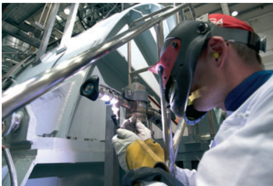
Impulssiventtiin asennushitsausta.
