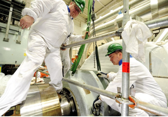
Kytintä asennetaan turbiinisalissa.
