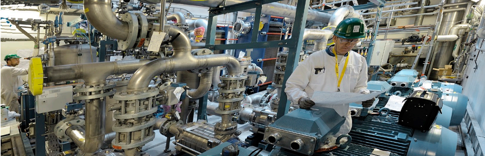
Generaattorin uuden jäähdytysjärjestelmän asennustyömaa.
