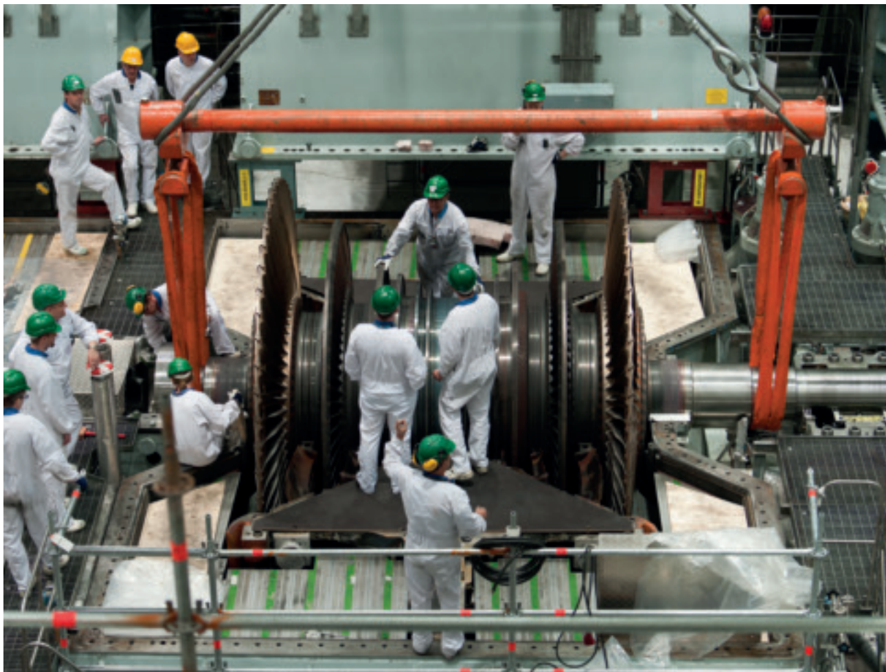
Matalapaineturbiinitöitä turbiinihallissa.
