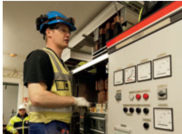
Dieselvarmistetun järjestelmän pääkojeistohuone vaatii noin 150 neliön tilan, joten kyseessä on iso kojeistokokonaisuus.
