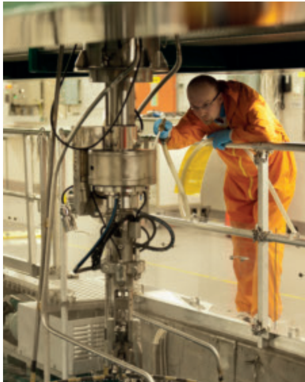
RTK-Palvelu Oy:n Jussi Leinon työtehtäviin kuuluu vuosihuoltojen aikana myös polttoaineensiirtokoneen tarttujan huuhteleminen.
