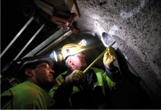
Jännitystilamittausta ONKALOn ajotunnelissa loppusijoitusvyödyllä.
