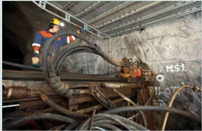
Testitunnelin pilottireiän kairausta loppusijoitusvyöhykellä ONKALOssa.
