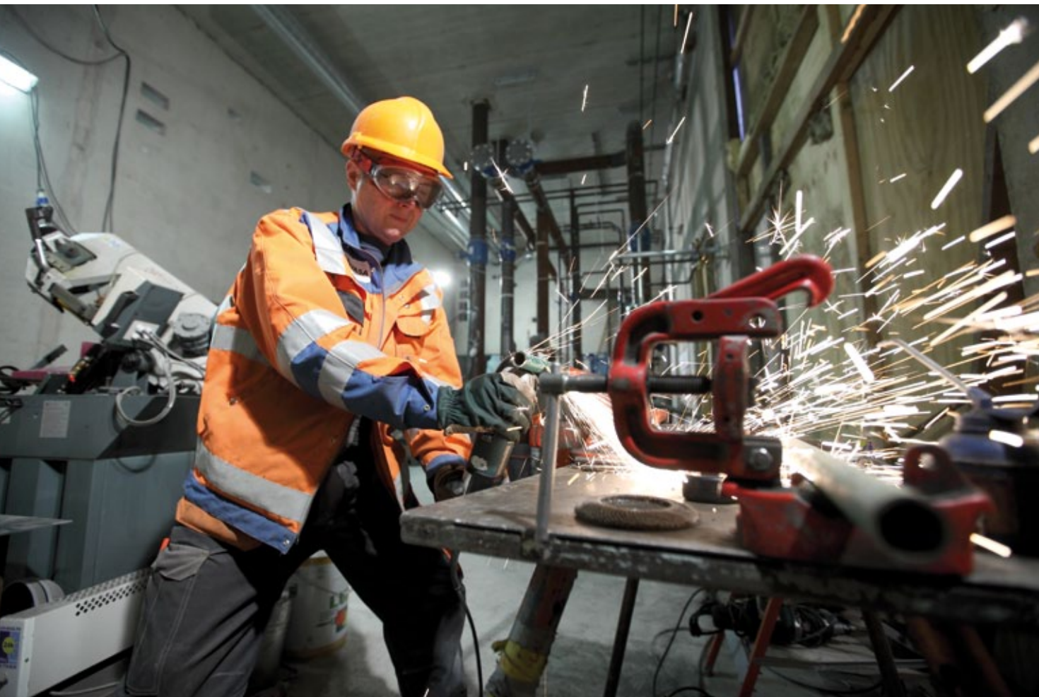
ONKALOn ilmanvaihtorakennuksessa päästiin sisätiloihin toimintavuoden lopulla.
