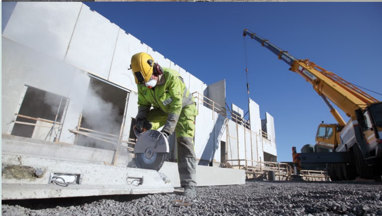
ONKALON ilmanvaihtorakennus saavutti harjakorkeuden loppuvuodesta.
