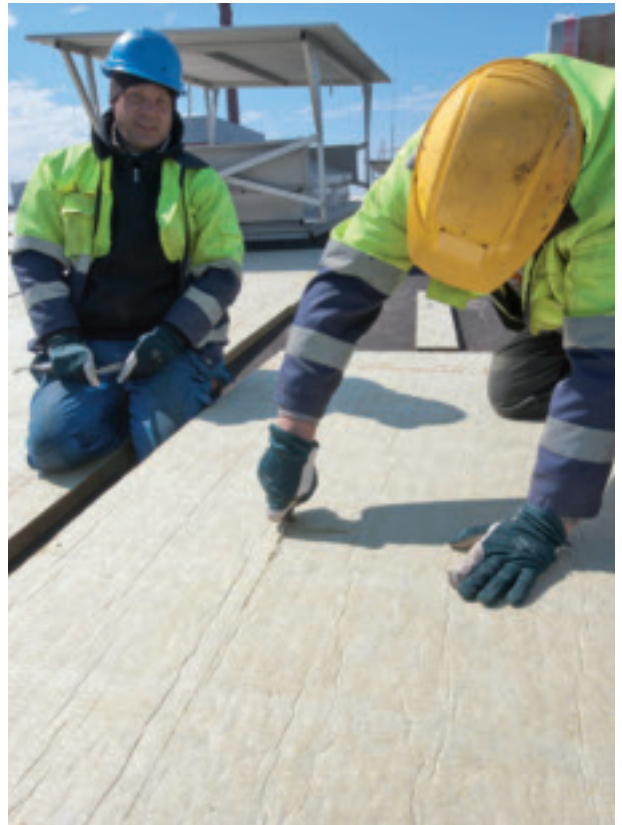
OL2:n turbiinirakennuksen katon huolto kuului vuoden 2011 vuosihuoltotöihin.
