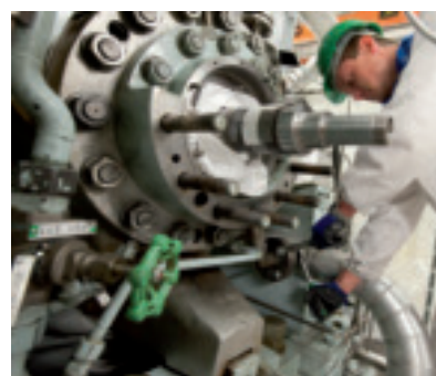
Syöttövesipumpun vuosihuoltoon kuului muun muassa liukurengas-tiivisteen vaihto sekä täydellinen kuntotarkastus.
