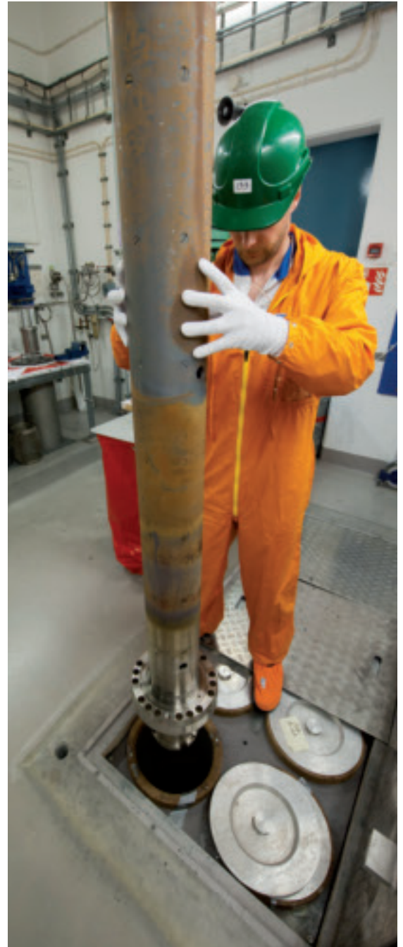
ALSTOM Finlandin Jussi Juntunen, Sami Mäkinen ja Vesa Laakso huoltavat säätösauvojen toimilaitteita huoltotilassa.
