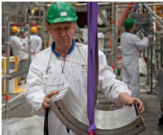
Turbiinin laakerisegmentti on tarkastettu ja puhdistettu huolellisesti ennen siirtoa paikalleen.
