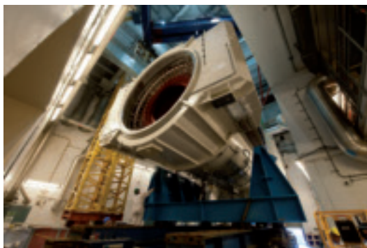
Generaattorin uuden staattorin nosto kuljetusalustalta.
