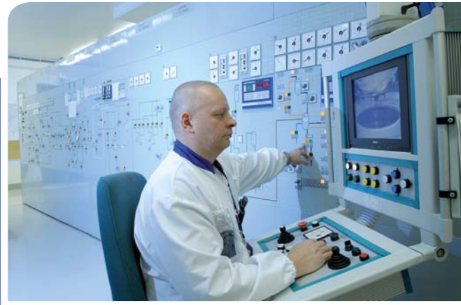
Prosessiveden puhdistuksessa käytetyt suodatinmassat kiinteytetään bitumiin ja seos valetaan terästynnyriin. Bitumointia ohjataan jätteenkäsittely-rakennuksen valvomosta.
