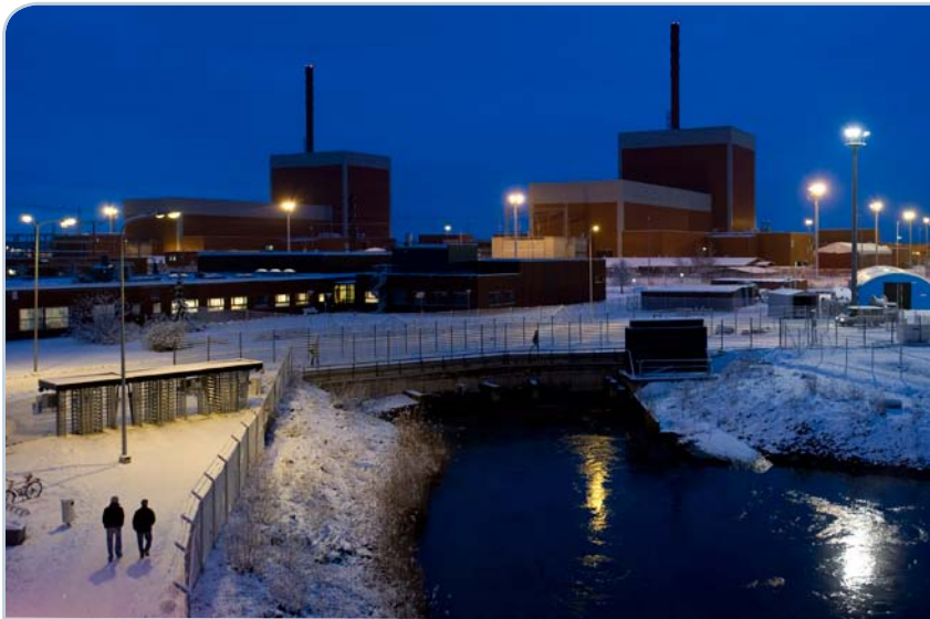
Merkittävin ympäristönäkökohtamme on jäähdytysveden lämpökuorma mereen.
