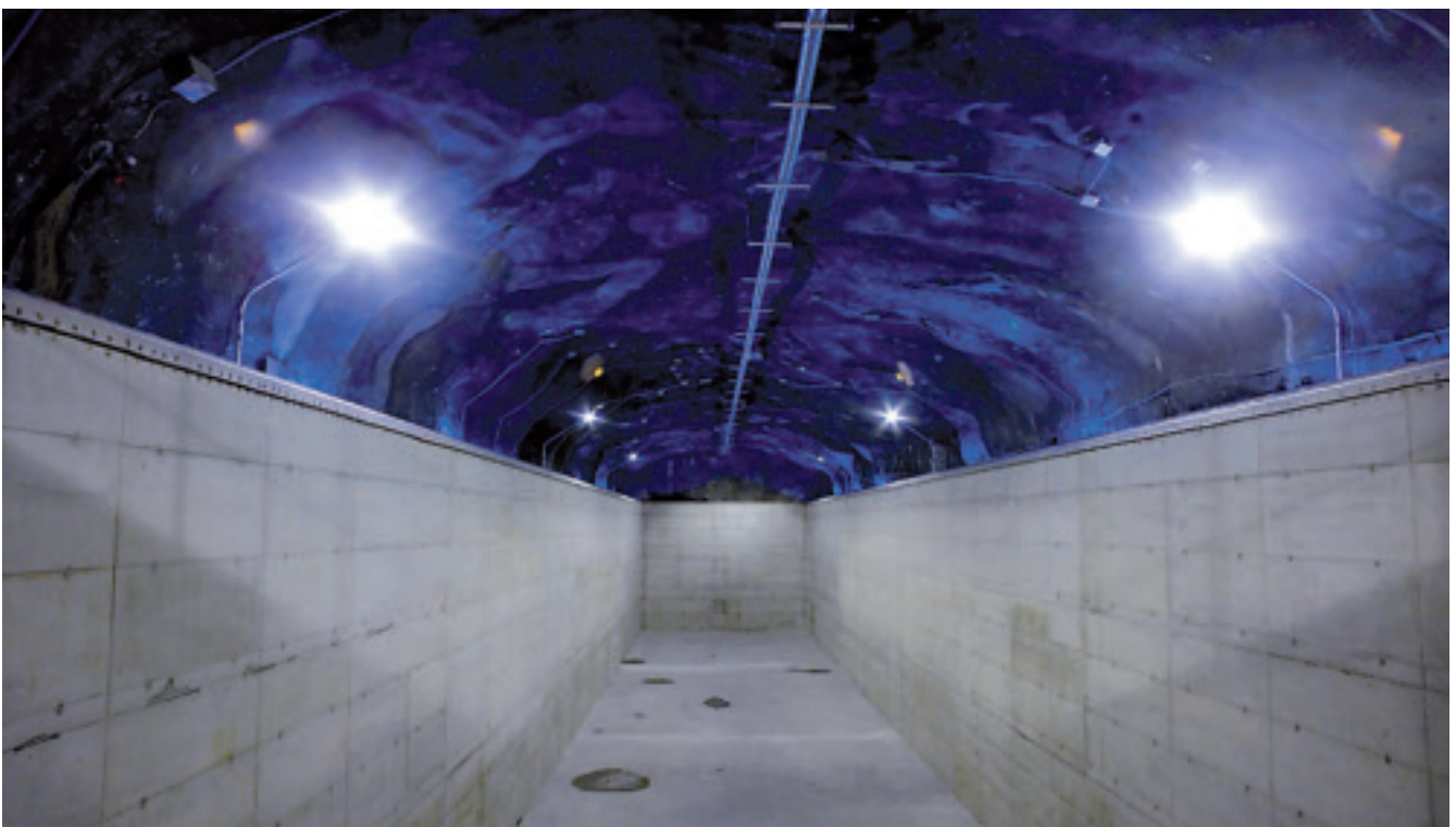
Loviisan voimalaitoksen kiinteytetyn jätteen loppusijoitustila.
