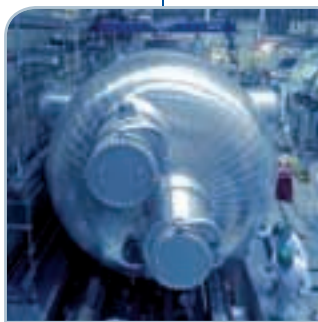
OL1-yksikön välitulistin uusittiin vuosihuollossa.
