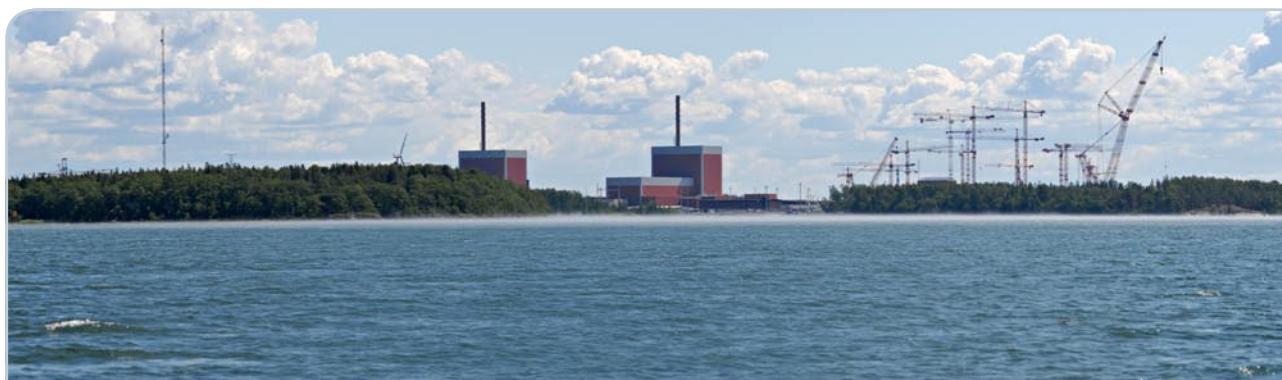
Bild 6. TVO:s kärnkraftverksområde sett från havet. På den övre bilden syns de befintliga enheterna OL1 och OL2 samt bygget vid OL3. På den nedre bilden finns ett fotomontage som visar de befintliga enheterna OL1 och OL2, den färdiga OL3 samt OL4 till höger på bilden.
