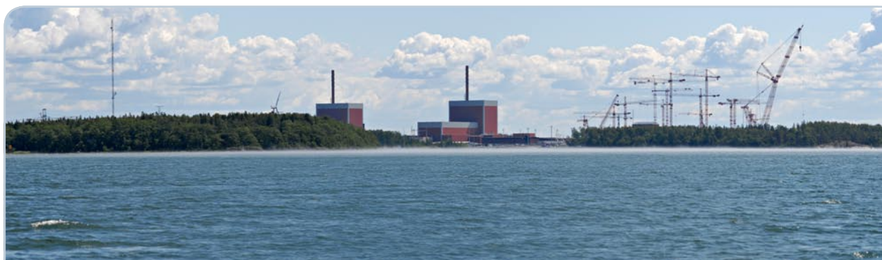
Bilde 6. TVOs kjernekraftverksområde sett fra havet. I det øverste bildet kan man se de nåværende enhetene OL1 og OL2 samt OL3's byggeplass. Det nederste bildet er en fototilpassning som viser de nåværende enhetene OL1 og OL2, ferdigstilt OL3 og OL4 til venstre på bildet.
