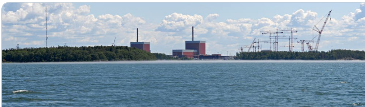
Joonis 6. TVO tuumajaama territoorium merelt vaadates. Ülemisel pildil on näha praegused üksused OL1 ja OL2 ning OL3 ehitusobjekt. Alumisel pildil on fototöötlus, kus on näha praegused üksused OL1 ja OL2, valminud OL3 ning OL4 fotol vasakul.
