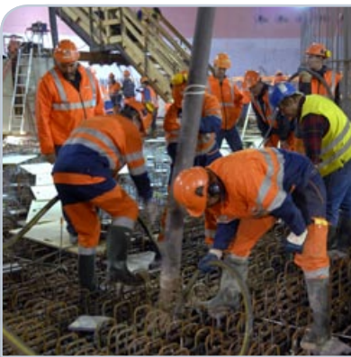
OL3-yksikön reaktorirakennuksen, polttoainerakennuksen, turvajärjestelmärakennusten ja jäte- ja apurakennusten rauditus- ja valutöitä tehtiin alkuvuonna.
