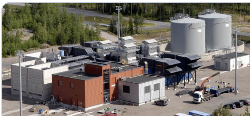
Kaasaturpiinivoimalaitoksen vihkiäiset pidettiin marraskuussa 2007.
