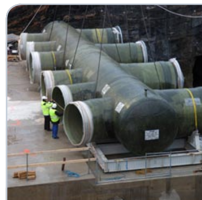
Merivesipumput pumpaavat jäähdytysvettä, joka johdetaan merivesilauhduttimeen jakotukin välityksellä.
