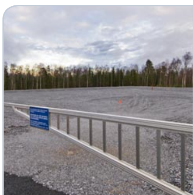
Marraskuun alussa käyttöön otetun Olkiluodon uuden kaatopaikan pohjarakenteissa hyödynnettiin työmailla muodostunutta ylijäämäbetonia. Kaatopaikan suunniteltu käyttöikä on 40 vuotta ja käyttöön otettu pinta-ala 0,6 ha, mikä on oleellisesti pienempi kuin vanhan kaatopaikan, koska kaatopaikalle loppusijoitetun jätteen määrää on tehokkaasti vähennetty.
