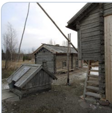
TVO korjaa voimalaitoksen läheisyydessä olevaa Raunelan vanhaa kalastajatilaa säästävän korjausrakentamisen periaatteella ja Satakunnan museon tarkkojen ohjeiden mukaan. Vanha savusauna on noin 100-vuotias.
