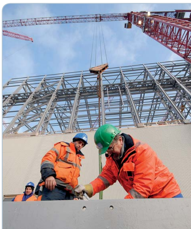
Kuva 8 Olkiluoto 3:n turpiinilaitoksen seinärakenteiden asennusta. Kuva: TVO.
