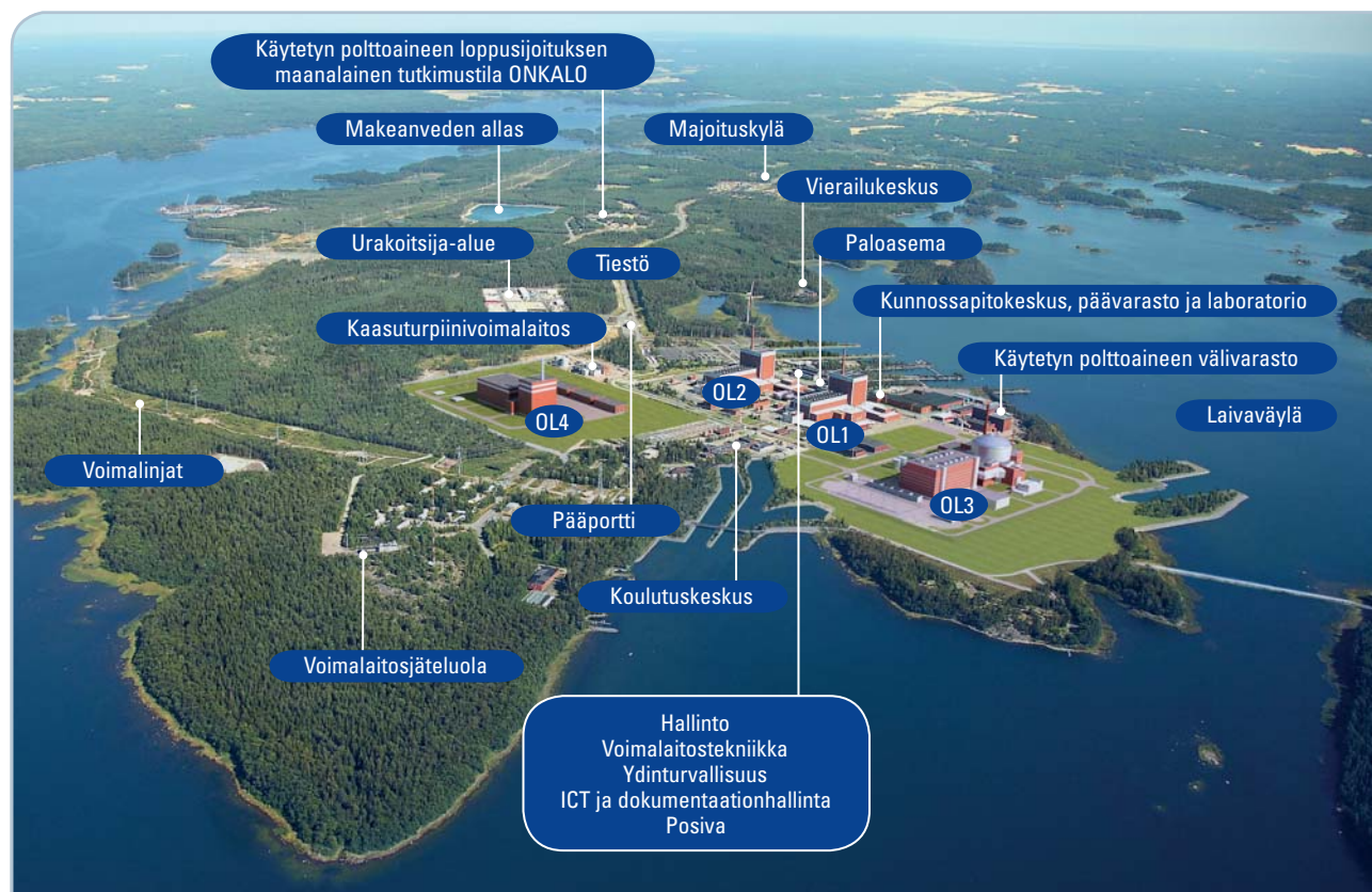
Kuva 5 Olkiluotoon lähes neljän vuosikymmenen aikana kehitetty infrastruktuuri on valmis OL4-laitosyksikölle. Sovitekuvassa OL4 valmiina. Kuva: TVO.
