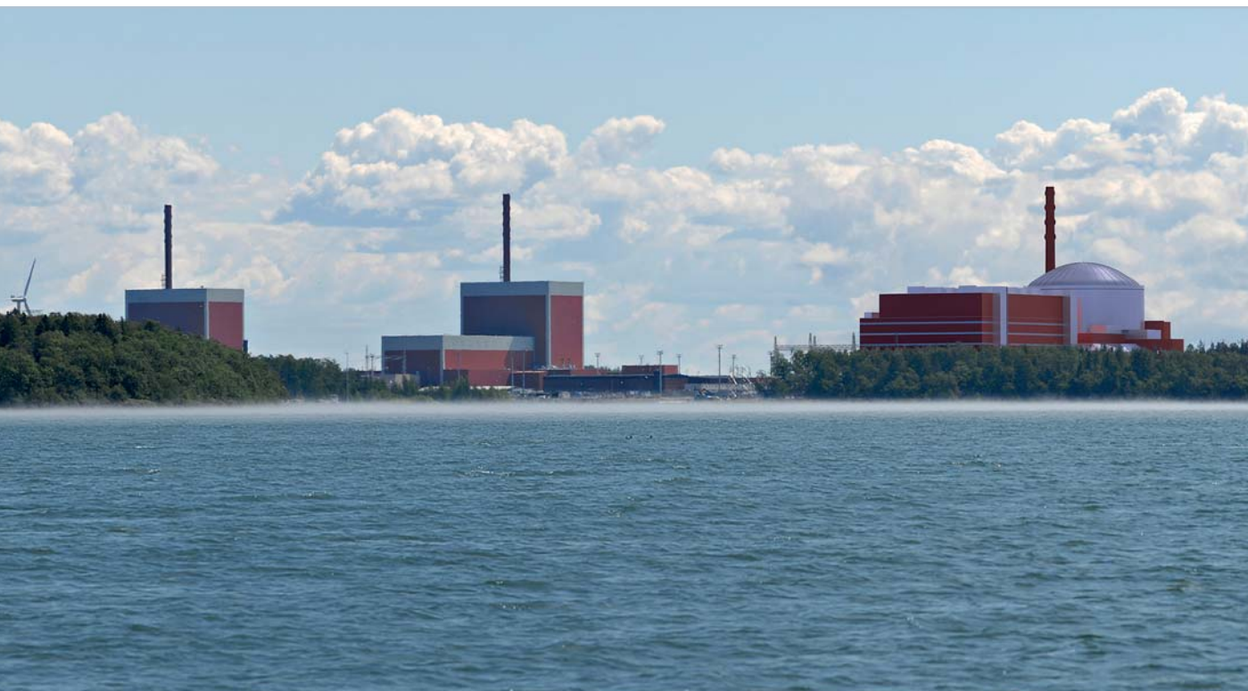
Kuva 12 Valokuvasoite Olkiluodon saaresta mereltä päin katsottuna. Kuvassa vasemmalla OL4, keskellä nykyiset yksiköt OL1 ja OL2 ja oikealla rakenteille oleva OL3. Kuva: TVO.
