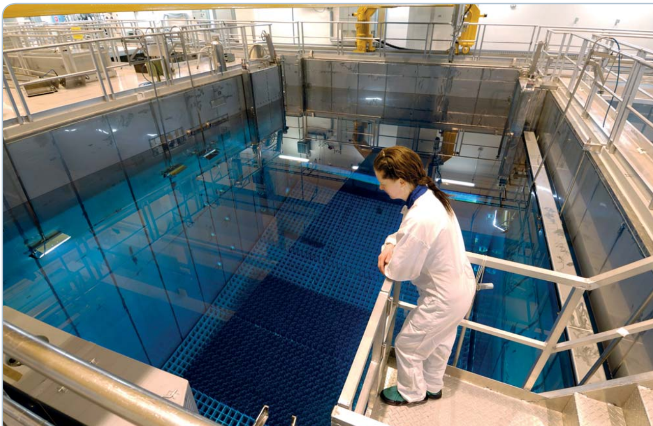
Kuva 17 Käytettyä polttoainetta välivarastoidaan vesialtaassa. Kuva: TVO.
