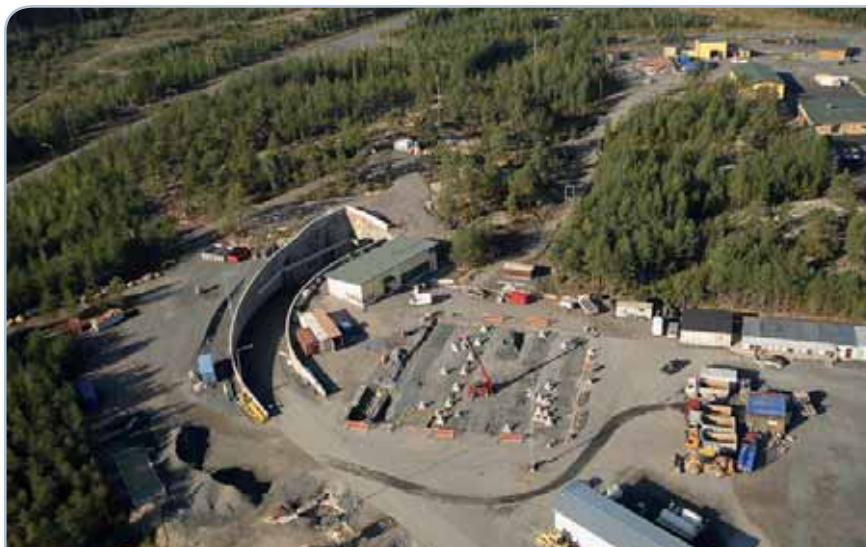
Bild 14–2 Öppningen på tunneln till forskningsutrymmet (ONKALO) för slutförvaring av använt bränsle i Olkiluoto. Forskningsutrymmet utgör senare en del av slutförvar för använt bränsle.
